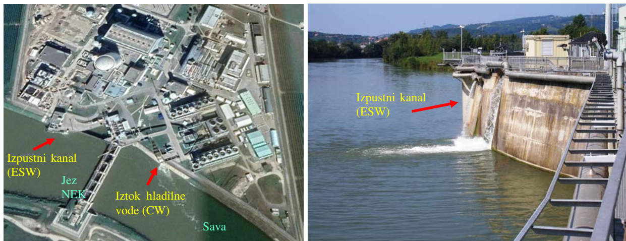
Slika 1.1: Izhod bistvene oskrbne vode (ESW), kjer se izpuščajo radioaktivne tekočine iz odpadnih merilnih rezervoarjev (WMT) in sistema za kaluženje uparjalnikov (SGBD). Fotografija na desni je posneta z jezca NEK.
