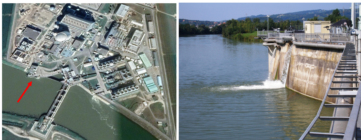
Slika 1.1: Izhod bistvene oskrbne vode (ESW), kjer se izpuščajo radioaktivne tekočine iz odpadnih merilnih rezervoarjev (WMT) in sistema za kaluženje uparjalnikov (SGBD). ). Fotografija na desni je posneta z jeza.
